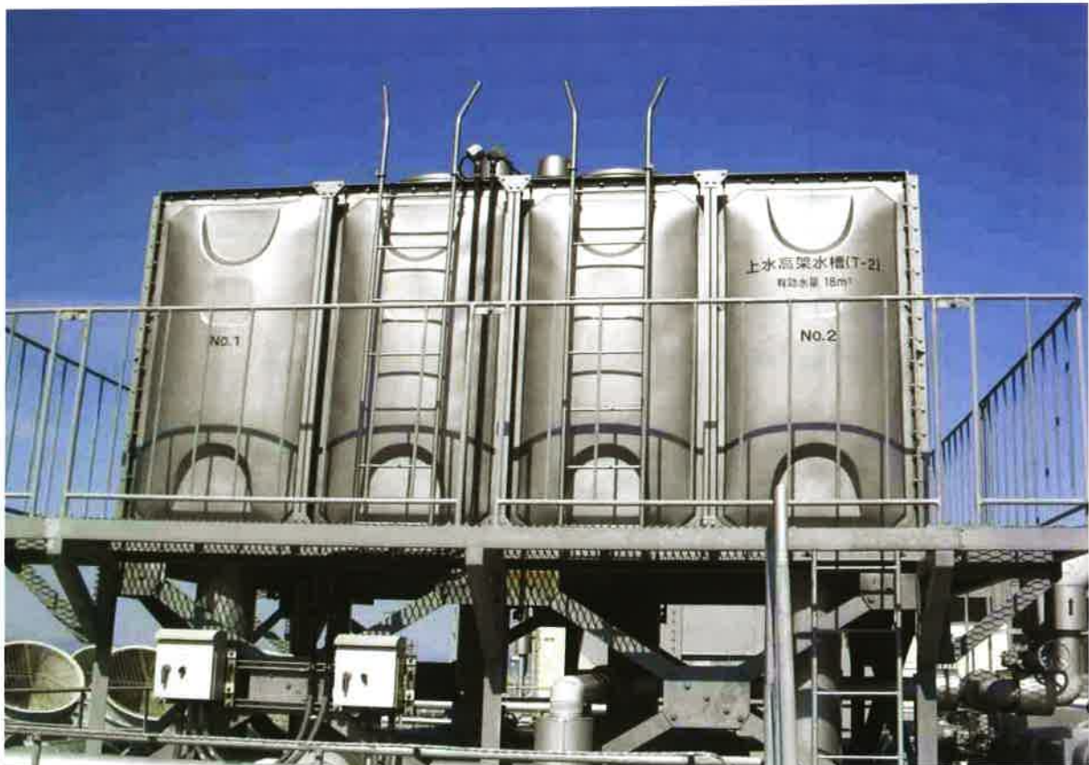
高層ビル高架水槽メンテナンス塗装（フェニックスAUタイプ仕上げ）
