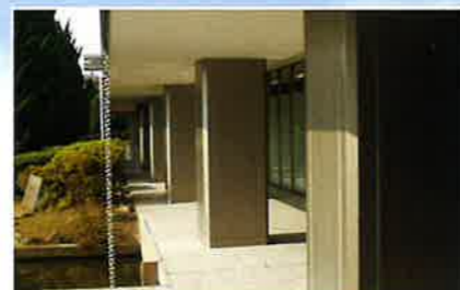
JFEスチール(株)福山本館事務所(広島県)
